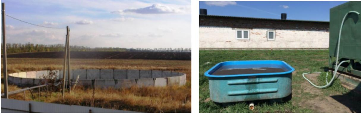
Рис. 5. Бетонный накопитель стоков и контрольная емкость (2,14 м³)
