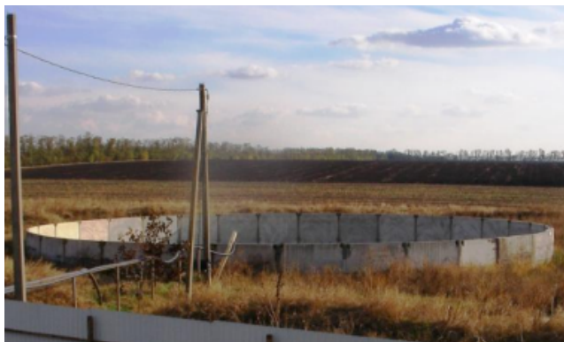
Рис. 5. Бетонный накопитель стоков и контрольная емкость (2,14 м³)
