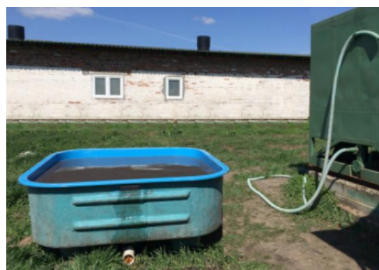
Рис. 5. Бетонный накопитель стоков и контрольная емкость (2,14 м³)
